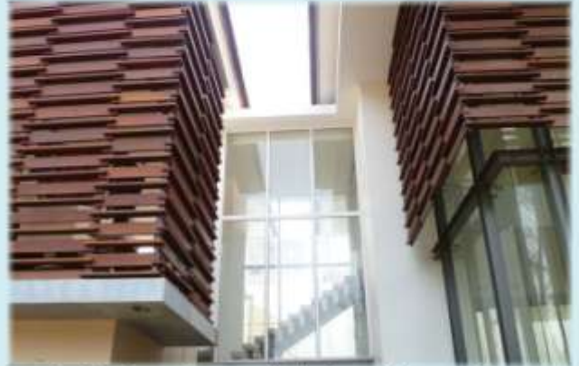
Jendela Ruang Tangga - Jl. Sinabung, Kebayoran Baru
