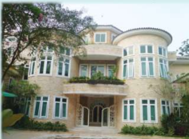
Pintu & Jendela - Bukit Golf, BSD City
